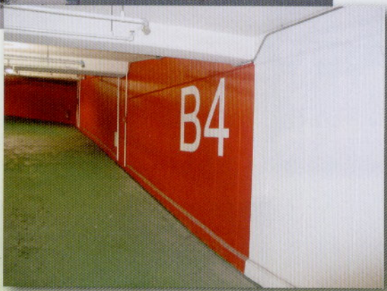
項目:地下室複壁工程 台北市:101金融中心
